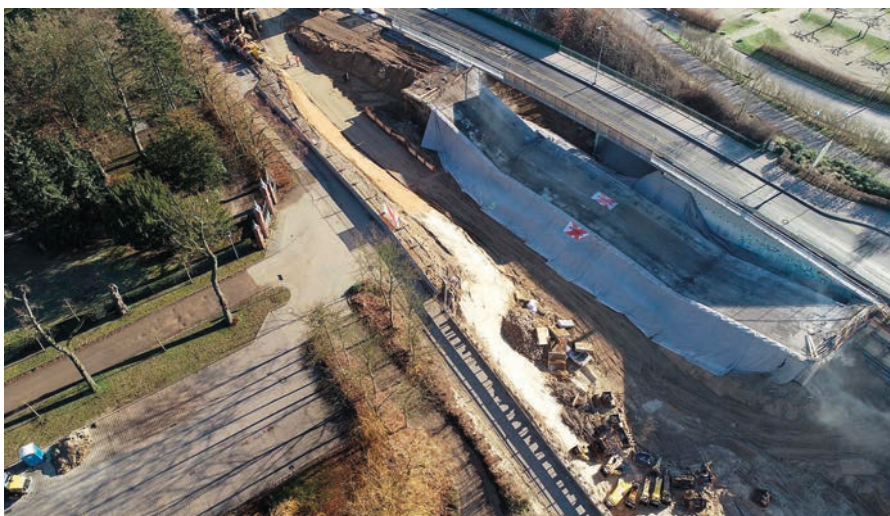
Niedergelegte Nordbrücke nach erfolgreicher Sprengung
