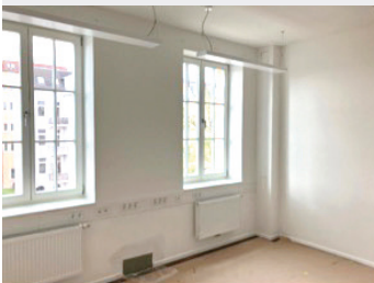
Die künftigen neuen Bürräume im Zuge der Sanierungsarbeiten
