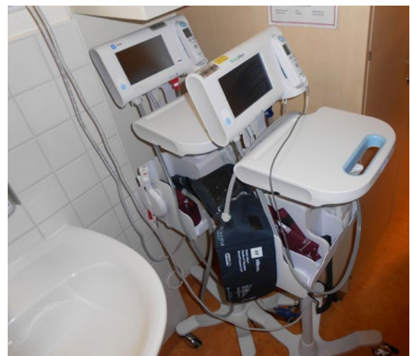
Foto aus einem Protokoll der Überwachung der Krankenhaushygiene: „Die Lagerung von Medizinprodukten direkt neben Waschbecken ist... zu vermeiden.“
