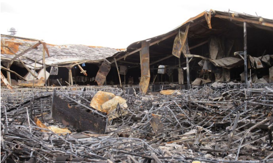
Komplett abgebrannte Stallanlage.
