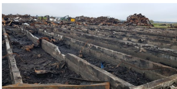
Abgeschlossene Brandschadensanierung oberhalb der Güllekanäle.
