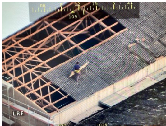
Observierung einer Baustelle per Helikopter
